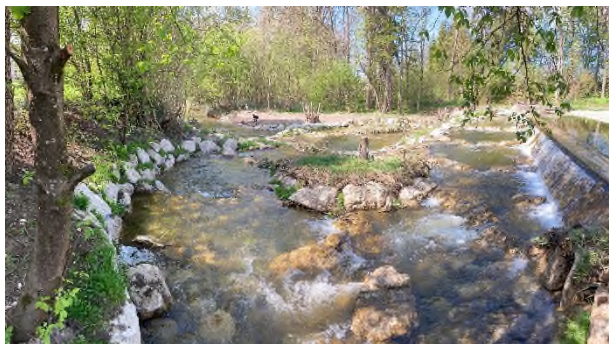
Abb. 1: zeigt die entstandene Blocksteinrampe. Im Vordergrund zu sehen sind die neu angelegten Strukturen im Wasser, die für mehr Vielfalt im Fließbild sorgen.
